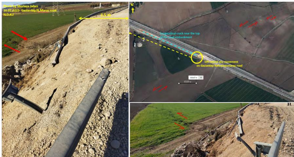
شکل (۷): گسیختگی سطحی زمین در جاده غازی‌انتپ- قهرمان‌ماراش در زلزله ۶ فوریه ۲۰۲۳ میلادی
