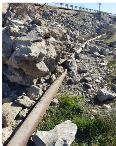
شکل (۲۳): آسیب‌دیدگی خطوط لوله در مسیر جاده آدیامان - قهرمان‌ماراش
