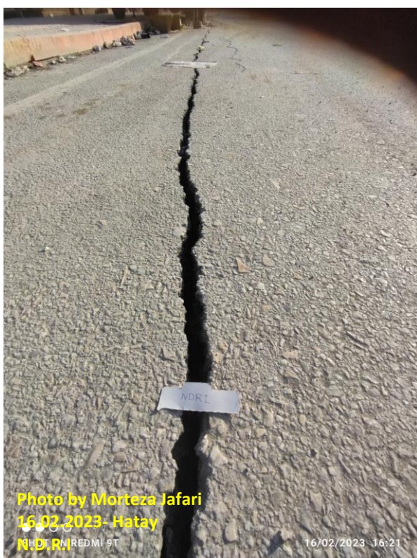
شکل (۲۲): گسیختگی سطح زمین در مسیر راه‌ها و بزرگراه‌های درون شهری
