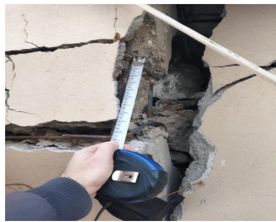
شکل (۱۷): عدم رعایت ابعاد هندسی مناسب برای تیرها و ستونهای بتنی، عدم رعایت فاصله خاموتها و شکست طبقه نرم
