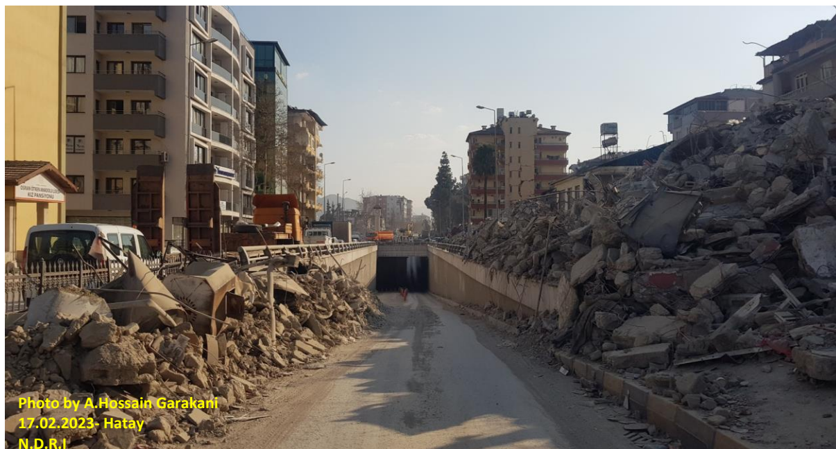
شکل (۳۱): حجم بالای آوار ناشی از ساختمان‌های تخریب شده در برخی شهرها و مشکلات زیست‌محیطی، دپوی آوار و سایر
