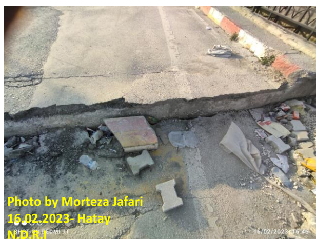
شکل (۲۰): آسیب‌دیدگی عرشه پل در شهر حاتای ترکیه و عدم امکان عبور و مرور وسایل نقلیه
