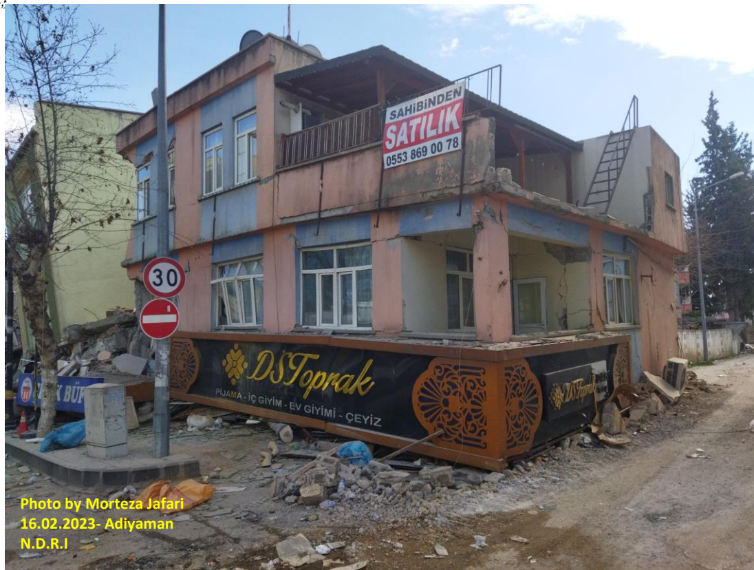
شکل (۱۳): انهدام کامل طبقه همکف به علت طبقه نرم
