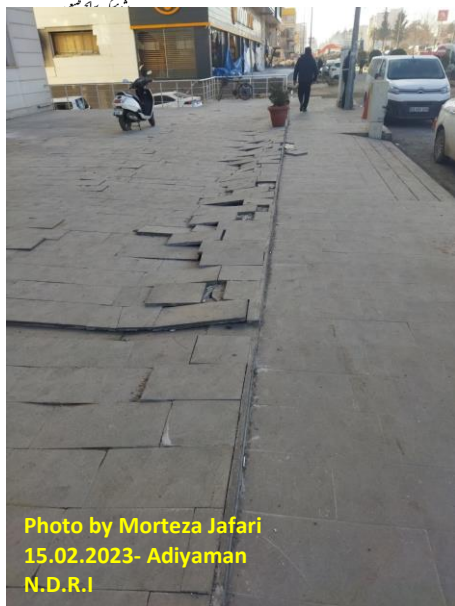
شکل (۸): روانگرایی و گسترش جانبی خاک در شهرهای آدیامان، گلباشی و حاتای
