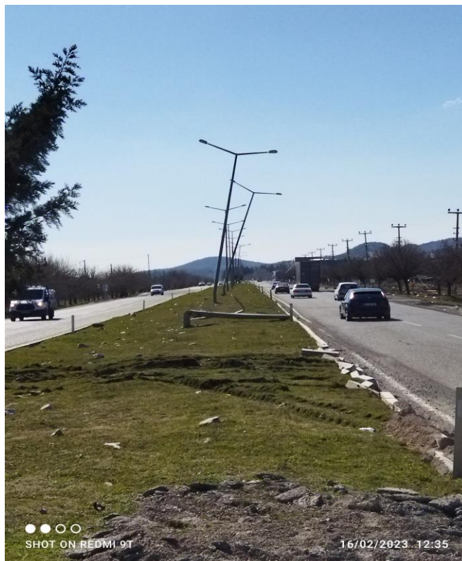
شکل (۲۴): آسیب‌دیدگی خطوط انتقال روشنایی (برق) در مسیر جاده قهرمان ماراش - حاتای
