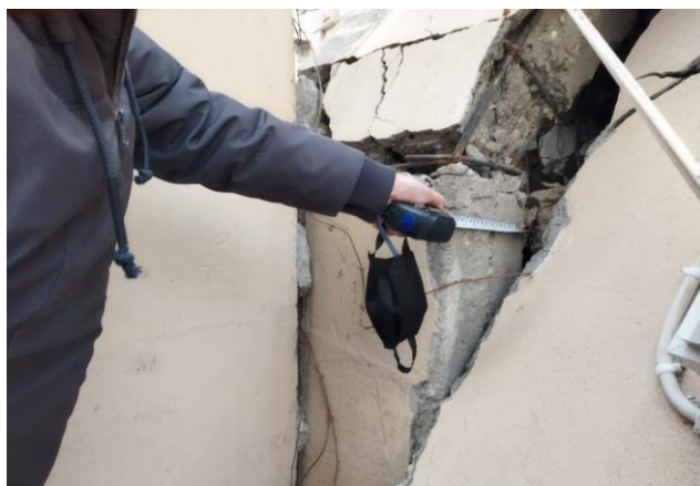
شکل (۱۷): عدم رعایت ابعاد هندسی مناسب برای تیرها و ستونهای بتنی، عدم رعایت فاصله خاموتها و شکست طبقه نرم
