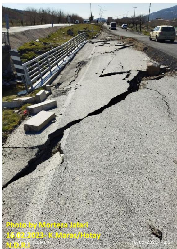
شکل (۲۲): گسیختگی سطح زمین در مسیر راه‌ها و بزرگراه‌های درون شهری
